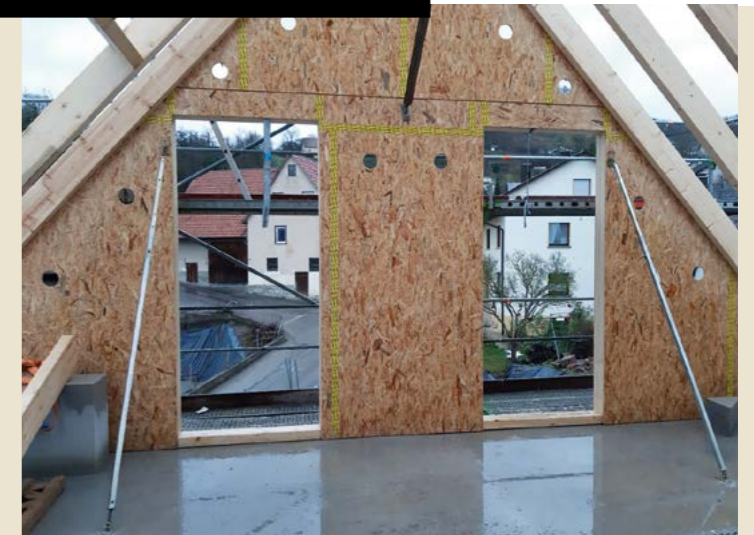
Die Innenseite der Fassade mit offenen Einblas-Löchern für die Zellulosedämmung
