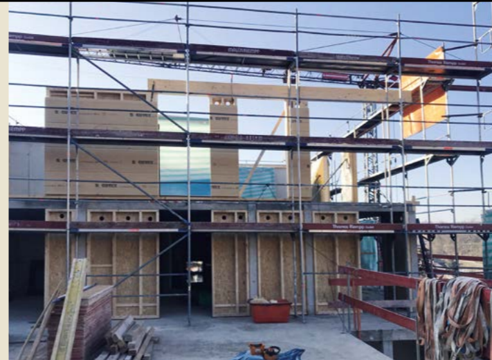
Massive, tragende Innenwände und Stützen werden durch die hochwärmegedämmten, maßgefertigten Holzfassadenelemente ergänzt
